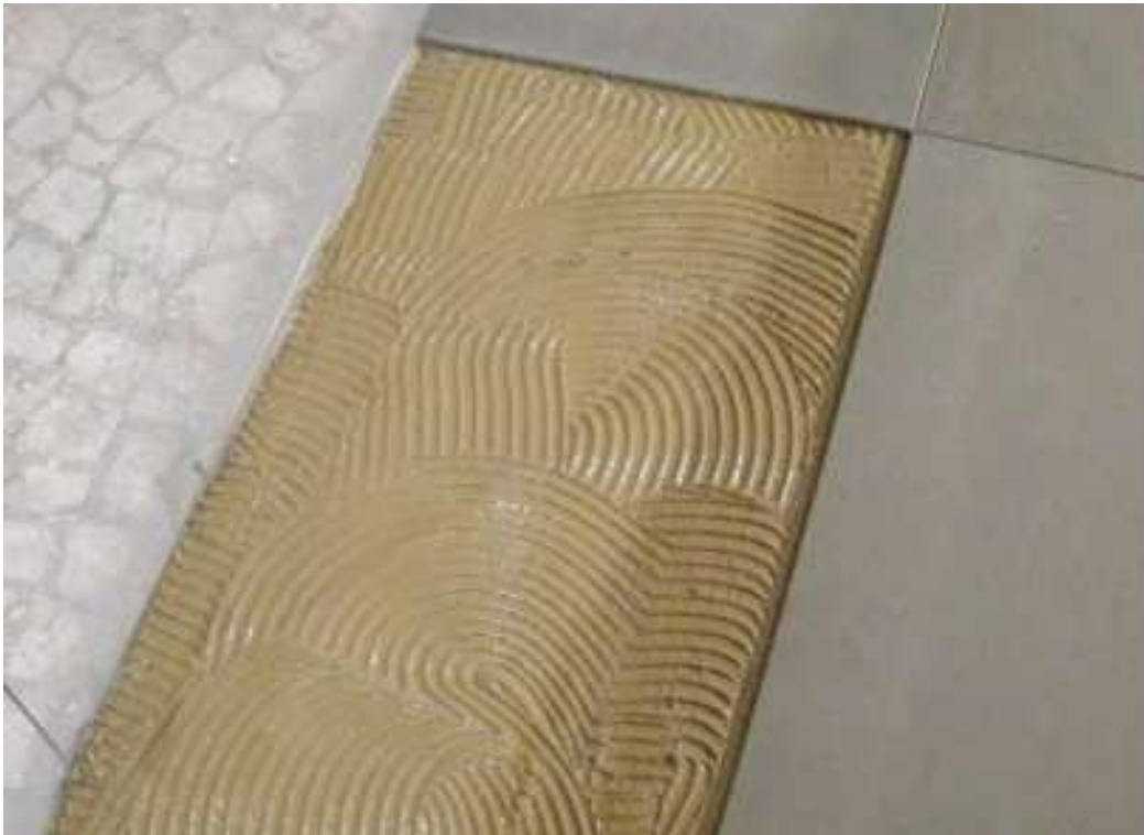
Figura 4.13 – Pavimento Viroc apoiado em suporte contínuo
