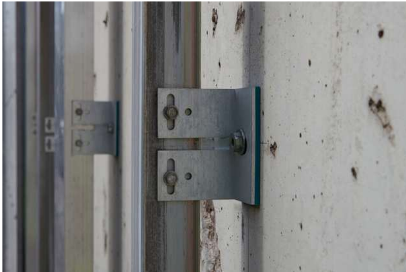
Figura 2.2.15 – Estrutura primária fixa com esquadros ao suporte
