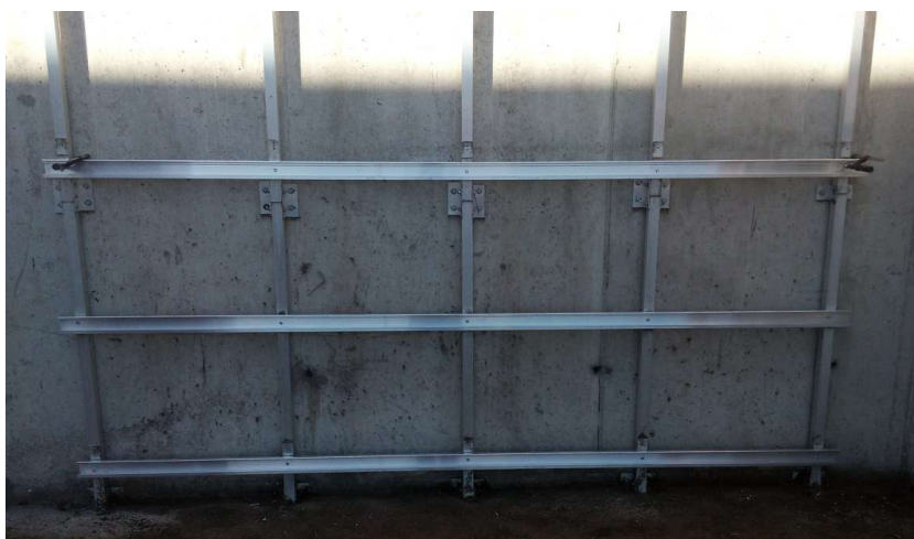
Figura 2.2.16 – Vista do perfil rail disposto na horizontal
